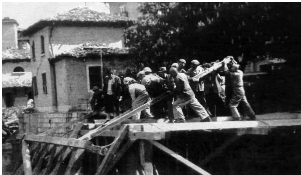
Početak izgradnje privremenog drvenog mosta preko Rječine 4. i 5. svibnja 1945. Projektant Maks Peč u sredini grupe sa šeširom
